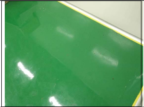
危废暂存库地面
